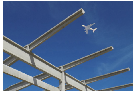
Vordachkonstruktion mit 10m Auskragung
