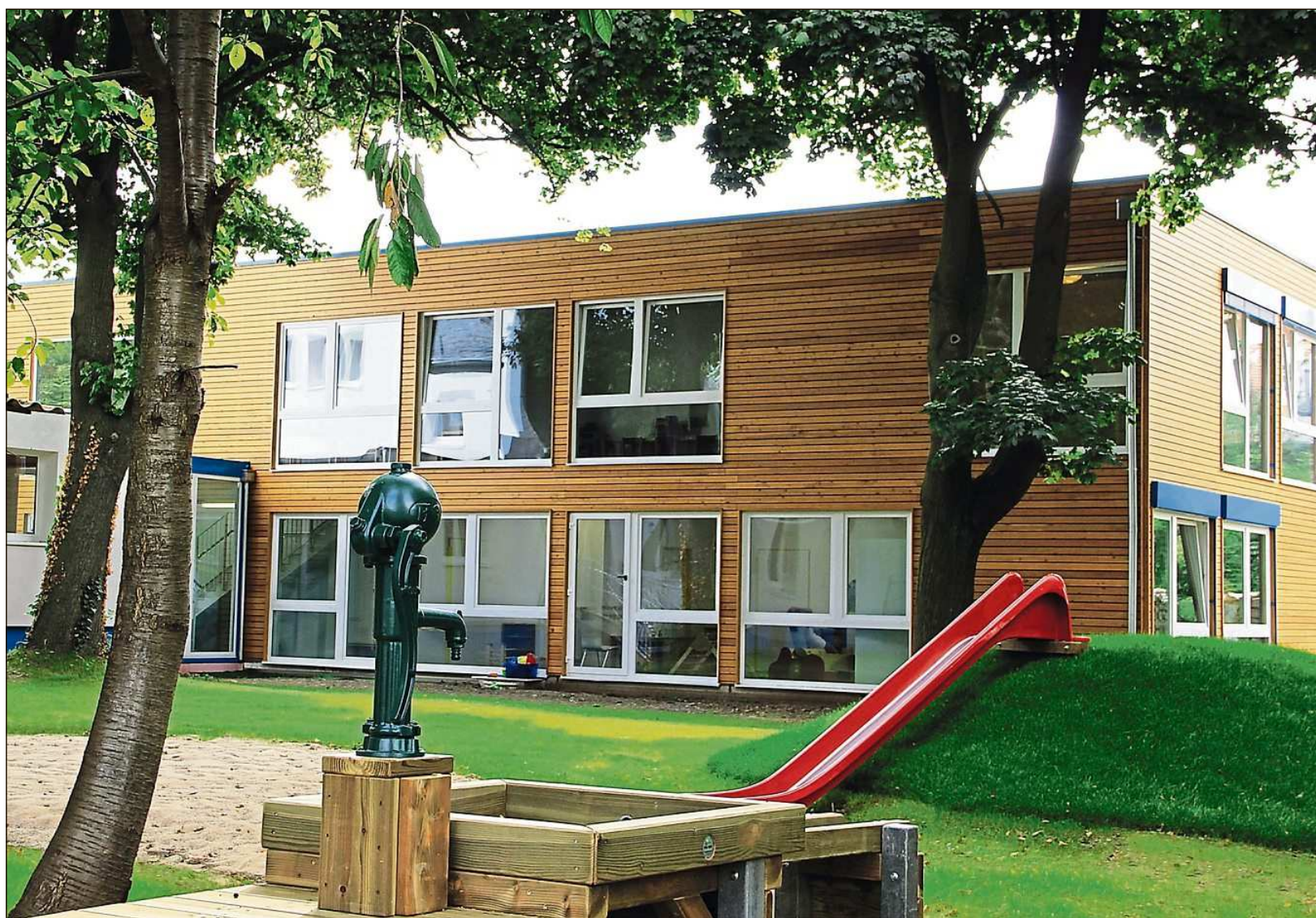
Im ersten Leben eine Kita, im nächsten vielleicht ein Studentenapartment: MyDagis in Köln, ein modularer Bau von Algeco, optisch ansprechend und in wenigen Wochen errichtet. FOTO ALGECO, ARCHITEKTEN: HANS-GEORG BAUM UND KATJA SCHMIDT
