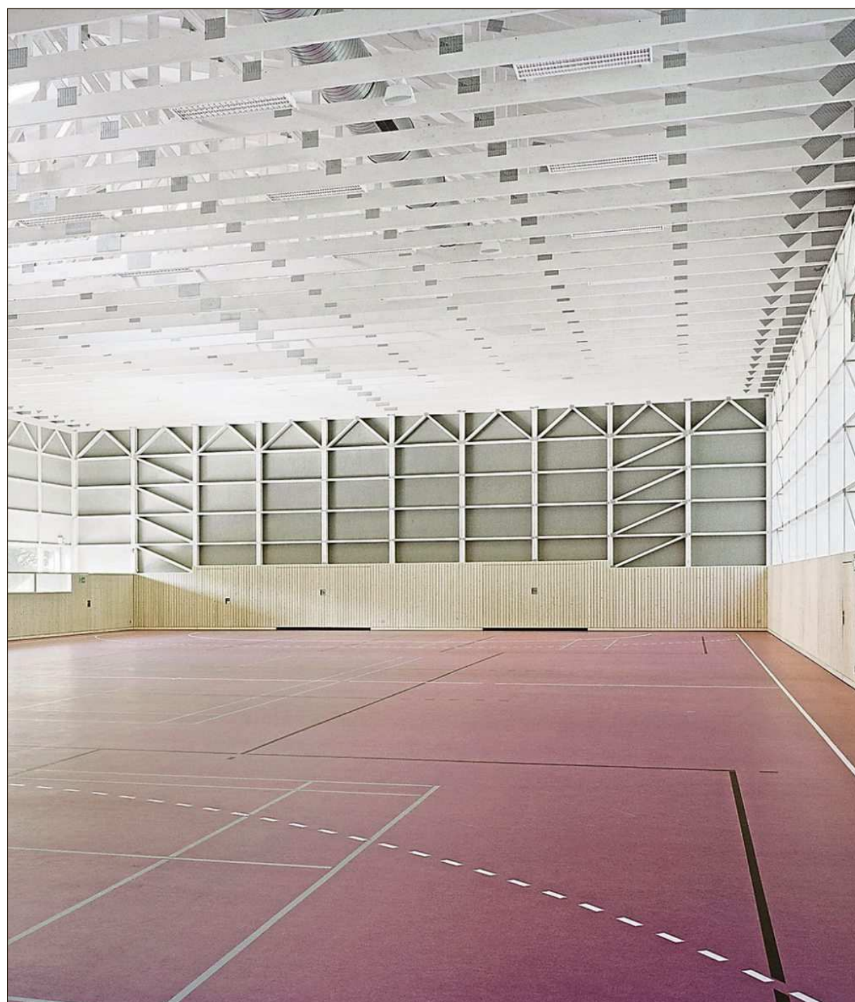
Die Sporthalle im oberbayerischen Haiming: Von der Jury ausgezeichnet als ein gelungenes Beispiel, wie sich auch unter strengster Kostendisziplin qualitativ hochwertige Architektur schaffen lässt. Die Konstruktion aus weiß eingefärbten Nagelplattenbindern wurde im Massinger Werk der Laumer Bautechnik gefertigt. FOTO SEBASTIAN SCHELS
