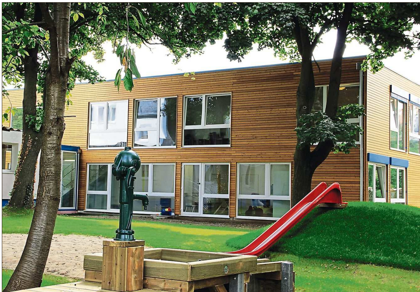
Im ersten Leben eine Kita, im nächsten vielleicht ein Studentenapartment: MyDagis in Köln, ein modularer Bau von Algeco, optisch ansprechend und in wenigen Wochen errichtet. FOTO ALGECO, ARCHITEKTEN: HANS-GEORG BAUM UND KATJA SCHMIDT
