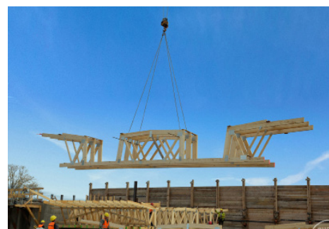
Lehrgerüst für den Brückenbau
