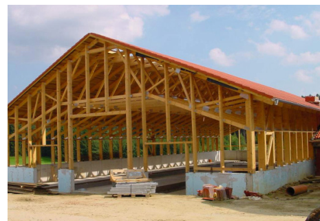
Hallenkonstruktion aus NP-Bindern
