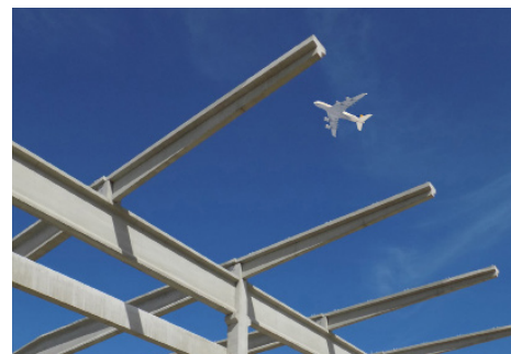
Vordachkonstruktion mit 10m Auskragung
