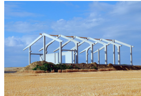
Rahmenkonstruktion aus Fertigteilen
