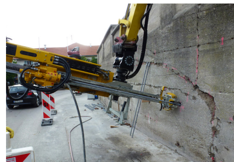
Gerät zur Herstellung von Mikropfählen
