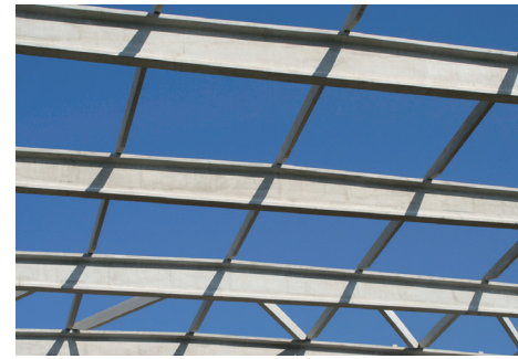
Betonfertigteilepfetten
