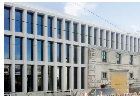
Fassade Stahlbetonfertigteile
